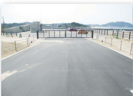
「北斗の水波み公園」側入口付近
